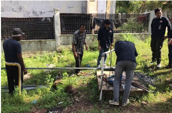
Gambar 3. Tim PKM USK melakukan pengecekan pompa
