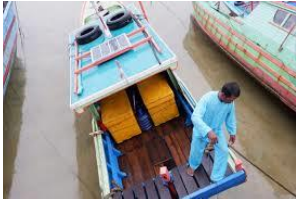
Gambar 3. Kegiatan pemasangan panel surya ditunjukkan pada
