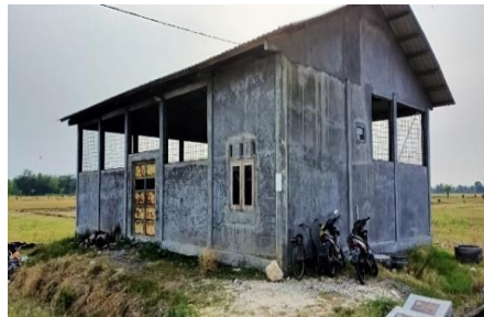
Gambar 2. Bangunan pusat pengolahan sampah di desa Cangkring
