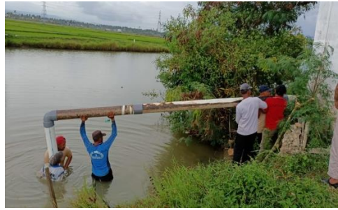
Gambar 5. Pemasangan pipa hisap ke kolam penampung air
