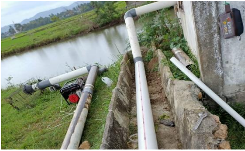
Gambar 4 Instalasi pipa hisap dan pipa buang.
