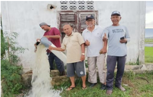
Gambar 6. Air berhasil dipompakan setelah perbaikan system
