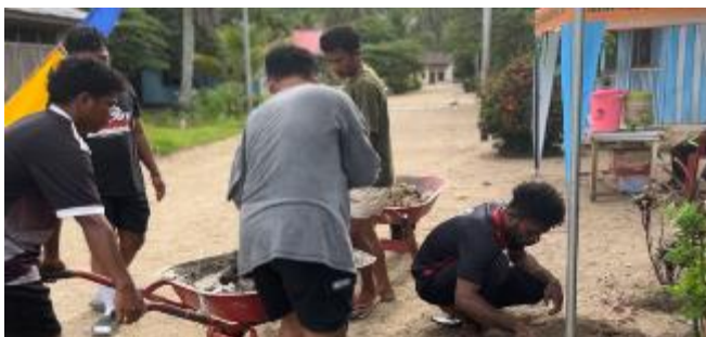
Gambar 5. Penandaan dan Pemasangan Rambu-Rambu Jalur Evakuasi
